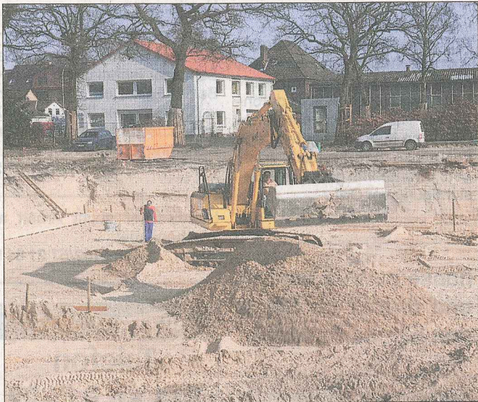
Der erste Bauabschnitt für die Eigentumswohnungen am Düpenauer Grund hat begonnen, der Bodenaushub ist bereits abgeschlossen.
