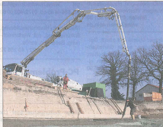
Beton marsch! Die Bauarbeiten am Flaßbarg sind in vollem Gange.
