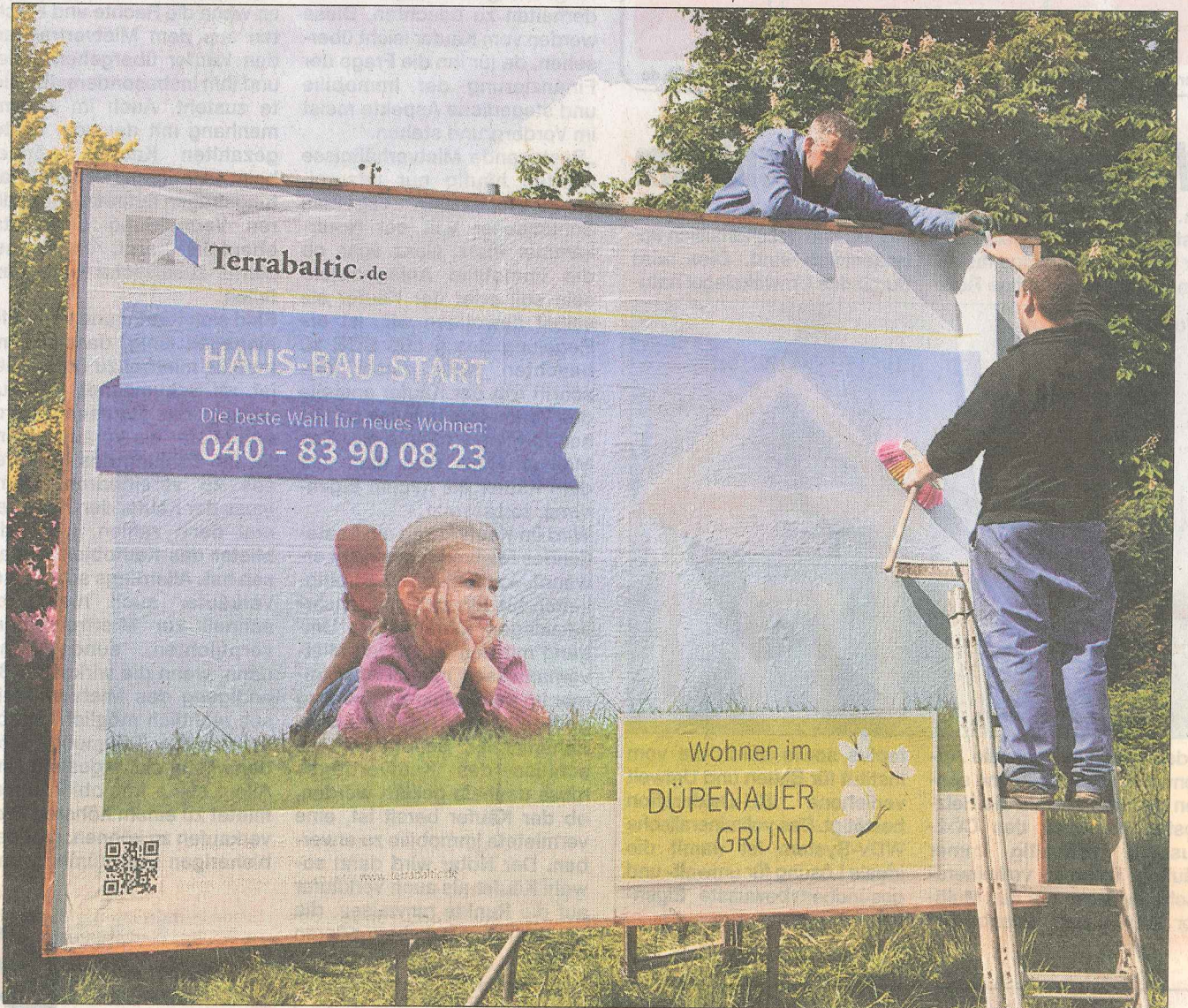
Geschafft, das Schild steht! Baubeginn für 18 familienfreundliche Häuser am Flaßberg. In weiteren Bauabschnitten folgen dann Eigentumswohnungen
